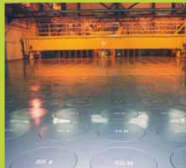
Entreposage de déchets HA.
