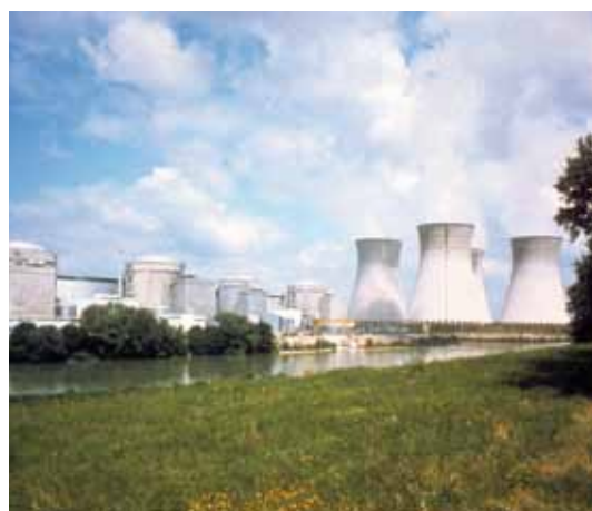
Centre nucléaire de production d'électricité du Bugey.
