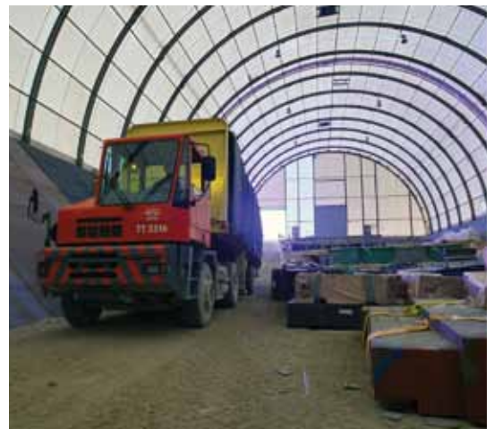
Stockage de colis TFA dans une alvéole du Cires.
