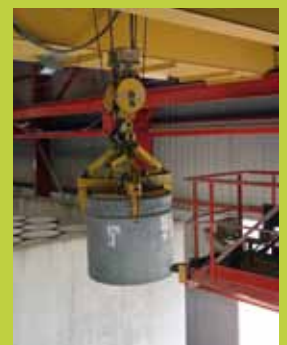
Stockage de déchets de faible et moyenne activité.
