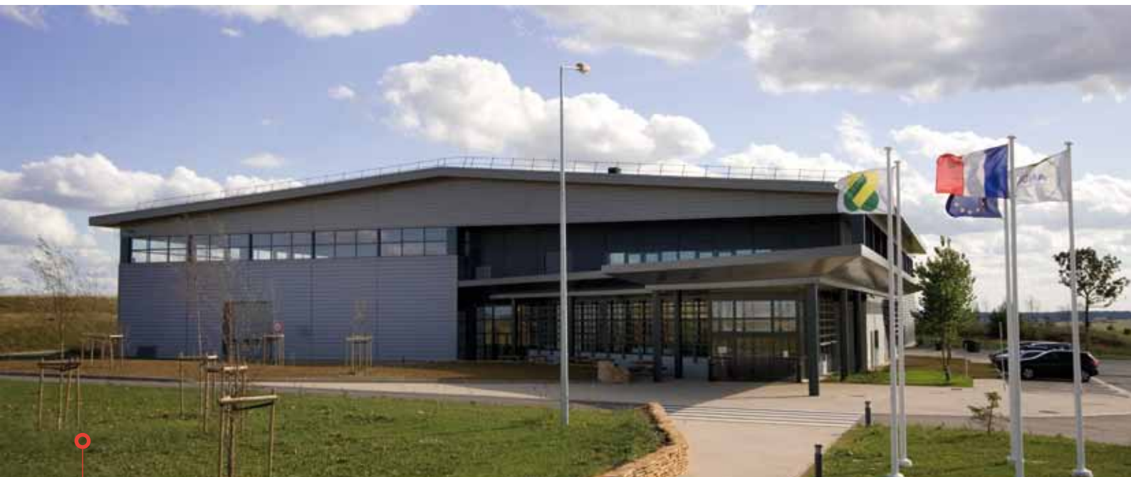
Espace technologique de l'Andra implanté sur la commune de Saudron, en Haute-Marne.
