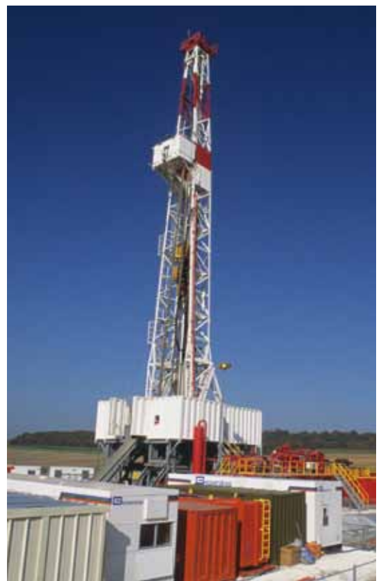
Plate-forme de forage.
