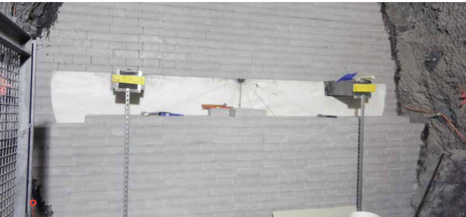
Expérimentation sur les scellements menée dans une galerie du Laboratoire souterrain.
