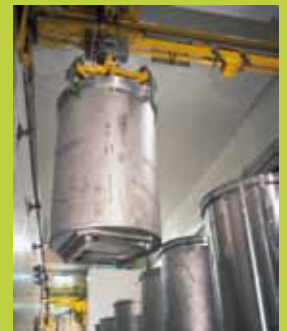
Entreposage de déchets MA-VL.
