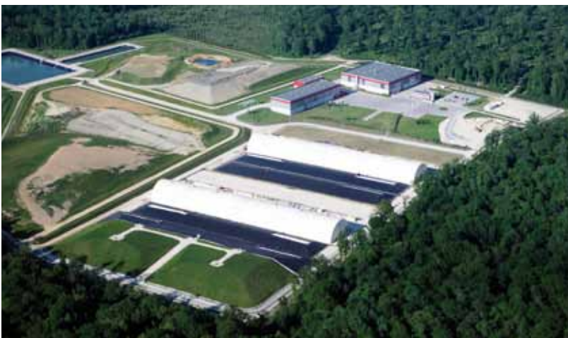
Vue aérienne du Centre industriel de regroupement, d'entreposage et de stockage (Cires).
